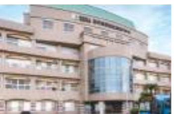
正面玄関の入口
